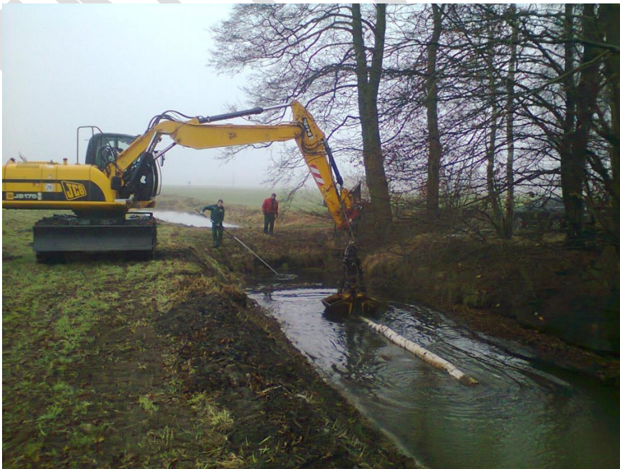
abflusssichernde Maßnahme, Freimachen eines verstopften Durchlasses
