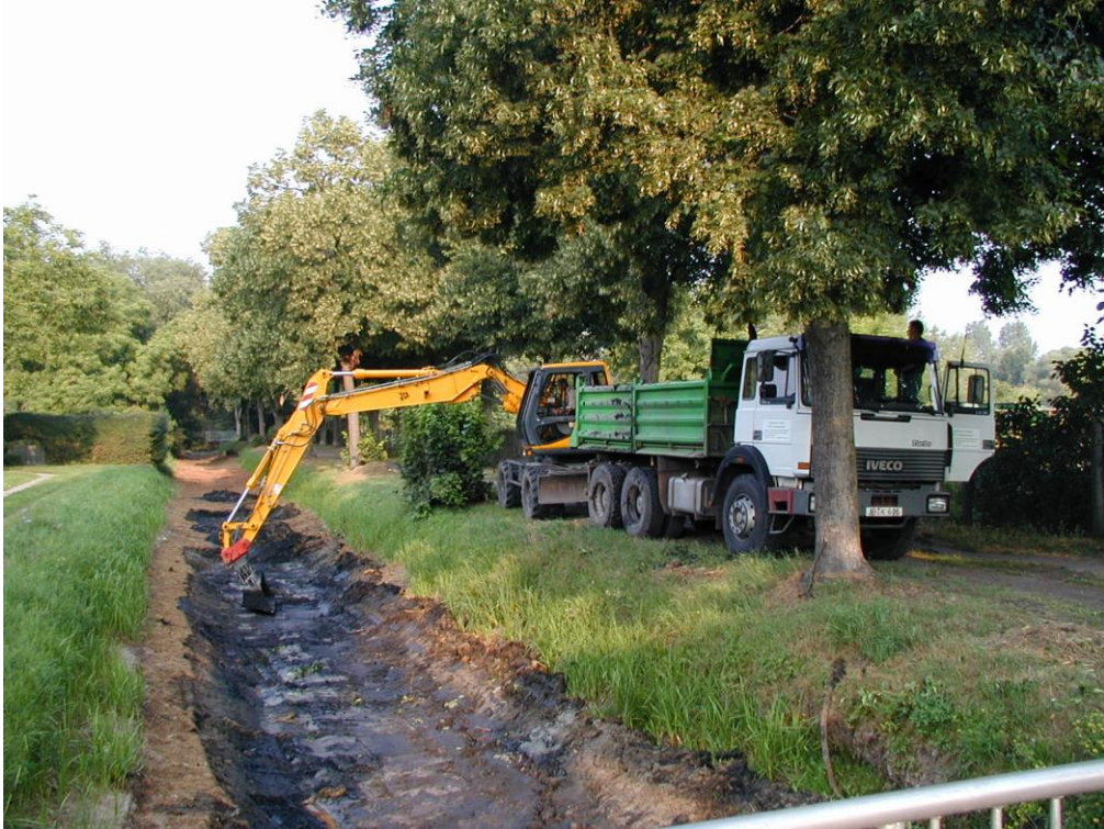
Herstellung des ursprünglichen Gewässerprofils
